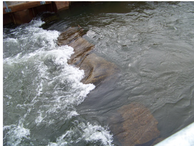
Querriegel aus Naturstein und Durchflussöffnung in der Fischaufstiegsanlage.
