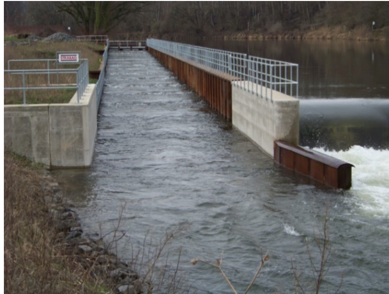
Fischaufstiegsanlage (Am Auslaufbereich)
