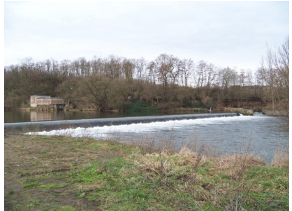
Muldenwehr und Gebäude für Brauchwasserentnahme. Rechts das alte Schützenbauwerk am ehemaligen Triebgrabenlauf.
